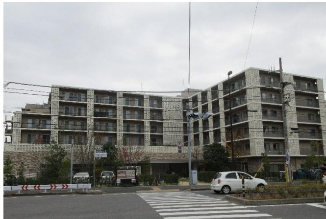
写真：オウカス船橋外観
