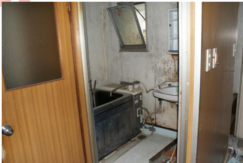
竣工当初の浴室
