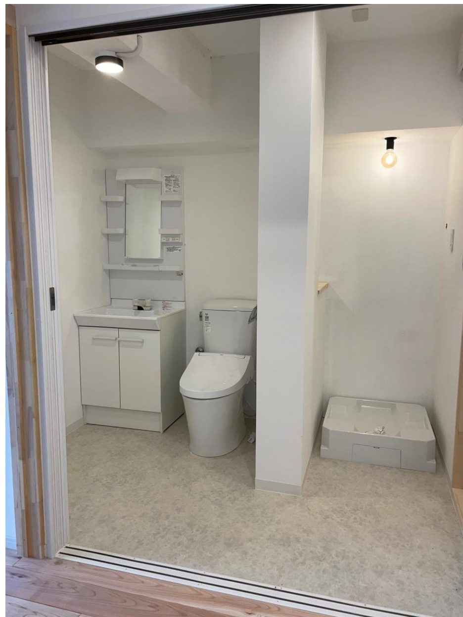
洗面・トイレ・洗濯機置き場改修
