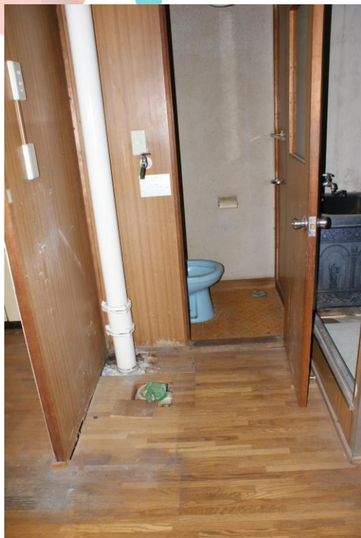
竣工当初トイレ
