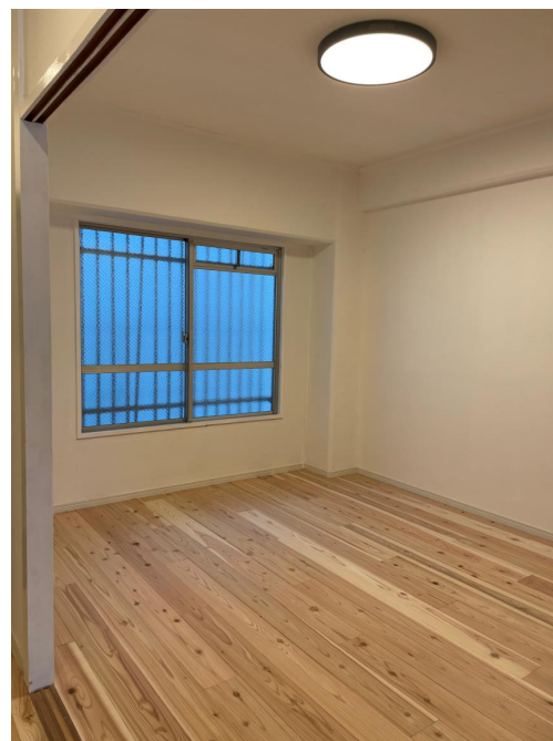
廊下側居室改修
