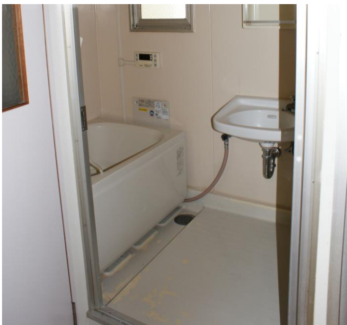
公社改修の浴室
